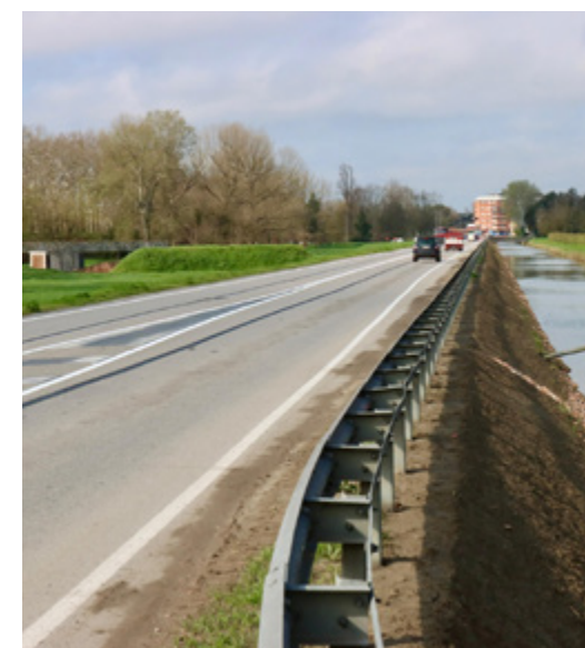
MANUTENZIONE SPONDE VIA GRAMICIA
