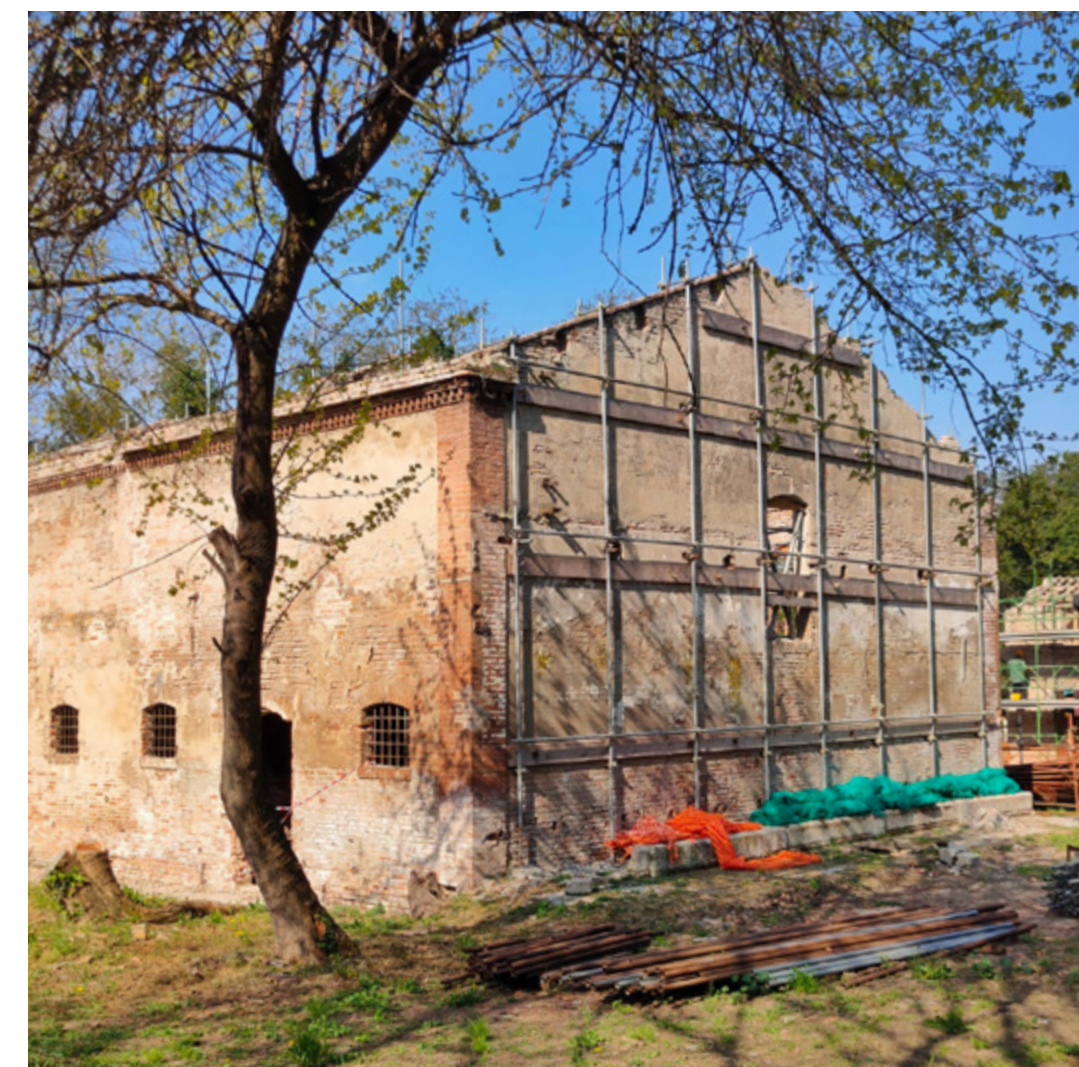
LA CASA DELL'ORTOLANO CANTIERE INSEDIATO E OPERAI AL LAVORO
